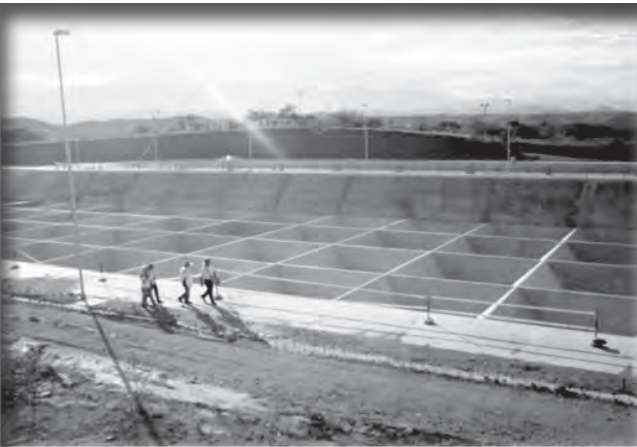
Desarenador ubicado cerca a la toma de agua del sistema de riego. Muestra la inmensidad de la obra en construcción. Octubre 2013.
