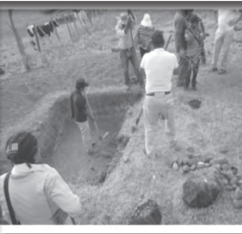
Construcción de reservorios de agua.
