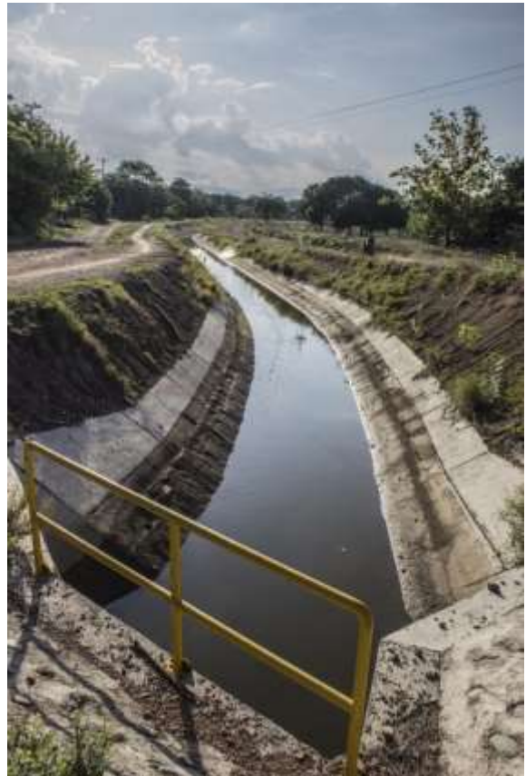
Uno de los canales principales del distrito de riego.
